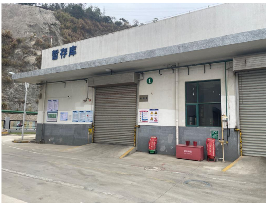
图 4-2 危废暂存车间图
